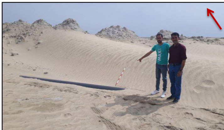
الصورة (5) زحف التجمعات الرملية نحو انبوب الخط الاستراتيجي النفطي في مدينة السماوة
